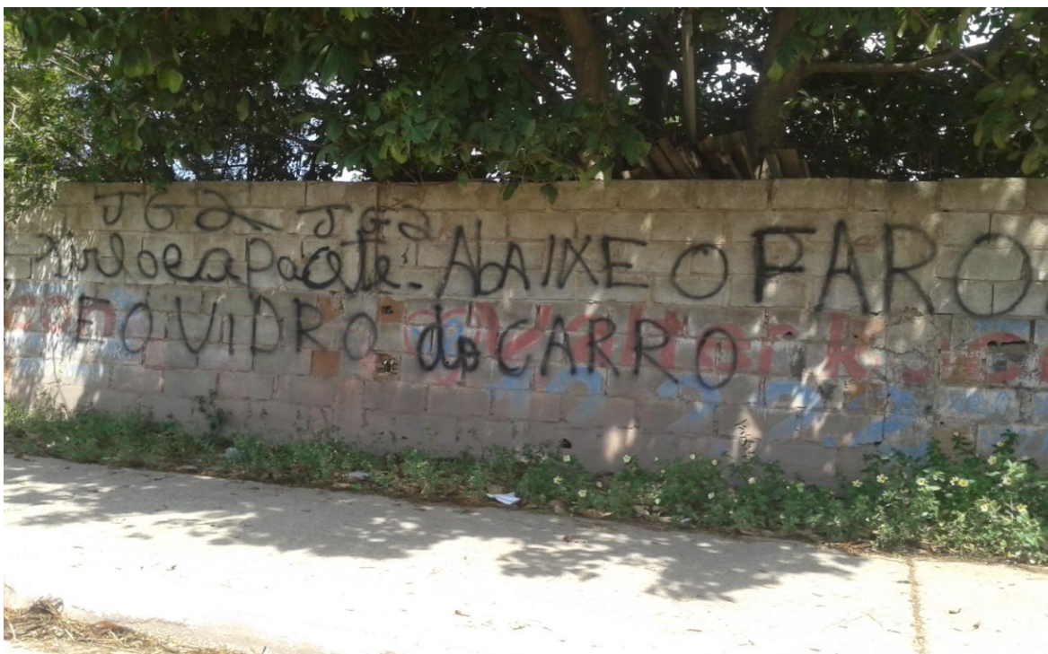
Rua Lateral da EMEF em Vila Velha/ES. Fonte: Arquivo do Grupo de Estudos da UVV
