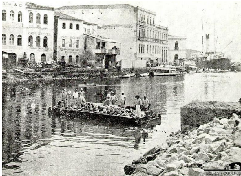
Figura 01 – Porto de Vitória. Início da construção do cais do Porto de Vitória – construção do enrocamento. Autoria: [Autor Desconhecido, 1918]. Fonte: UFES apud Memória Visual da Baía de Vitória (2014).
