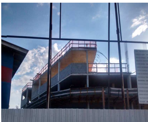
Figura 11: Obra de um hotel sendo construído ao lado da Favela Margem da Linha, maio de 2014. Arquivo: LEEA
