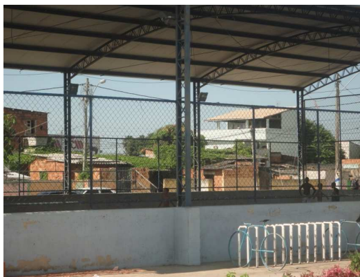
Figura 5: Quadra poliesportiva construída na Favela Tira Gosto, maio de 2014 arquivo: LEEA.
