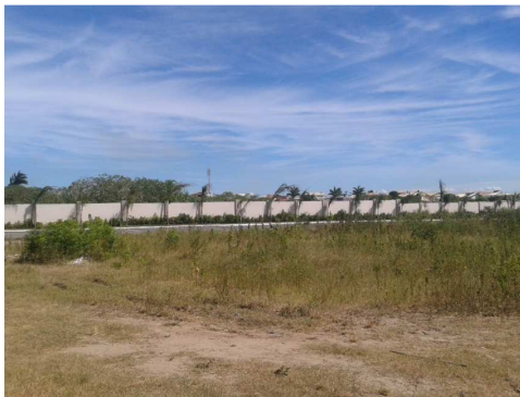
Figura 9: Estrada que separa a Margem da Linha do condomínio residencial em construção pela construtora MRV, março de 2014. Arquivo: LEEA
