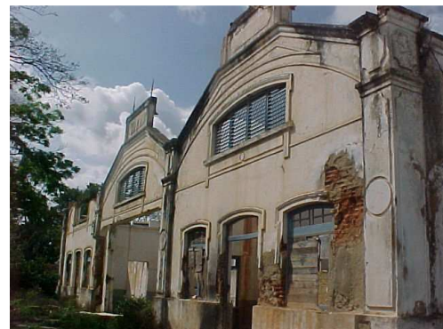
Figura 4: Fachada do antigo Matadouro em junho de 2006, arquivo: LEEA
